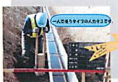
【水路の両側同時に埋戻しをおこなう締固めをします。埋戻し、締固めを数回繰り返します】
